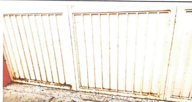
Foto 6: Reparacion de porton de ingreso.
