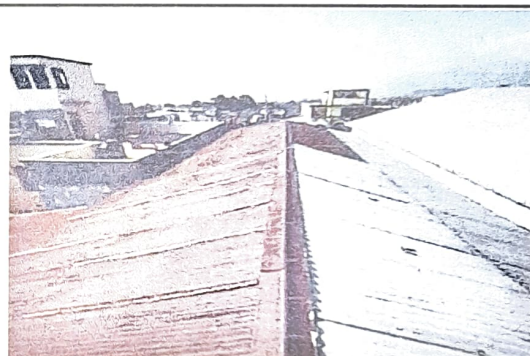
Foto 4: Cambio de techado
