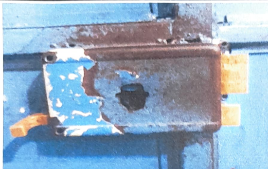
Foto 1: Cambio de chapas
